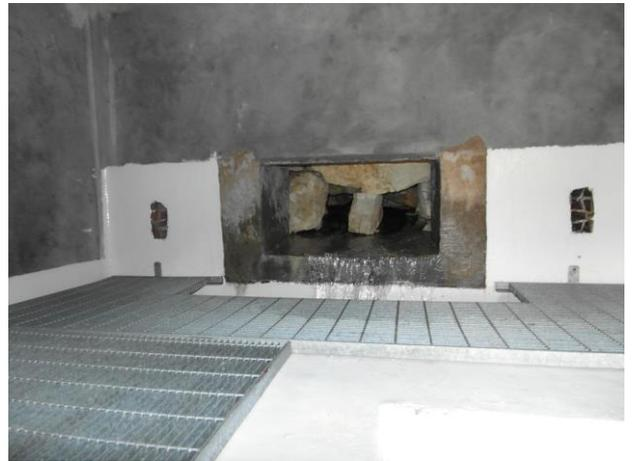
Fig.8.3 – Particolare dell'interno dell'opera di captazione.
