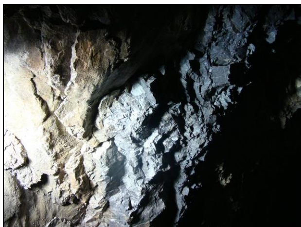
Fig.9.4 – Particolare della formazione della Corniola presente all'interno della principale galleria di captazione.
