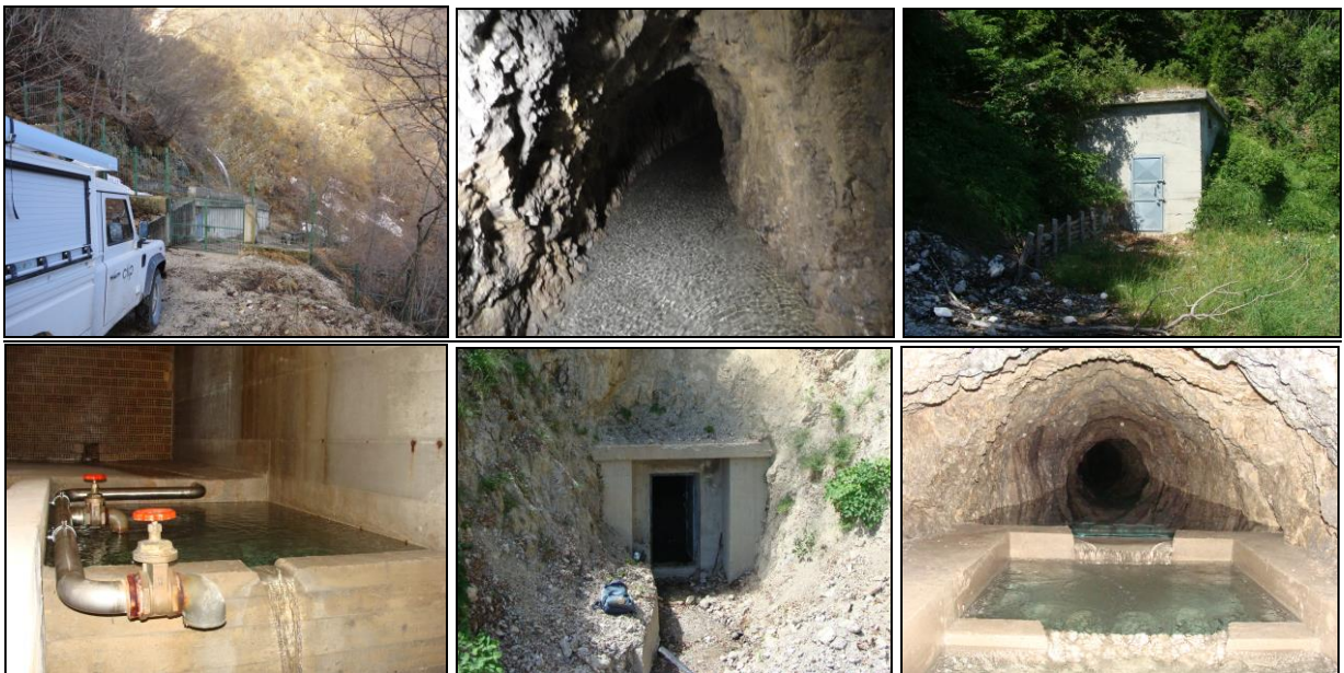
Fig.9.2 – Gruppo sorgenti Sasso Spaccato. In successione (da sinistra a destra); captazione inferiore e particolare della galleria di captazione; captazione intermedia e particolare della vasca di raccolta; captazione superiore e particolare dell'ingresso alla galleria drenante (foto 2012).
